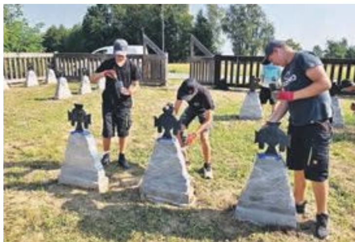
Die Arbeit geht nie aus – nach zwanzig, dreißig Jahren braucht jeder Friedhof wieder eine gründliche Sanierung.
