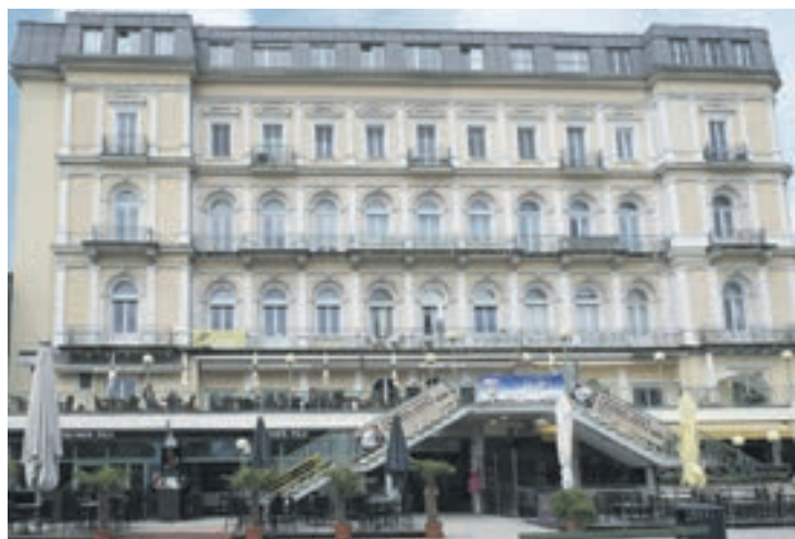
Zurzeit laufen Renovierungsarbeiten: Das Wiener Café im Hotel Austria sperrt noch heuer neu auf.
