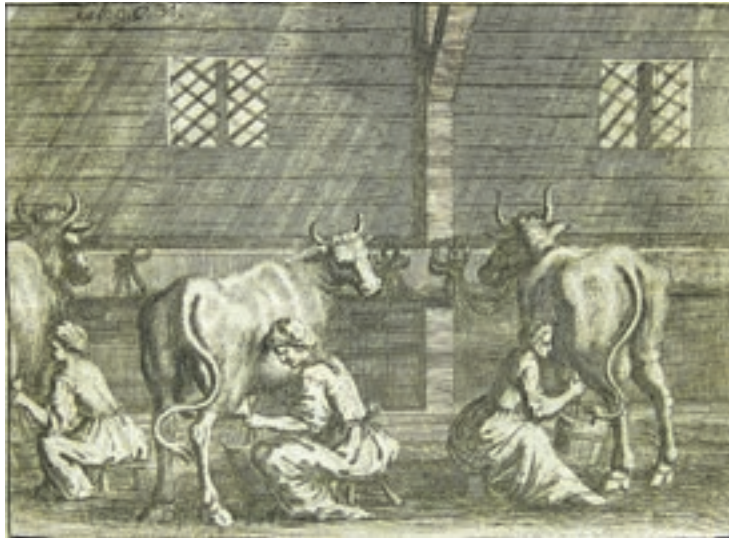
So hat er ausgesehen ein vorbildlicher Kuhstall vor bald 400 Jahren – in Wolf Helmhardt von Hohbergs „Georgica curiosa“.
