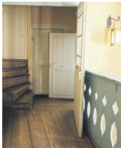
Stiegenhaus im Goethehaus in Weimar. Eineinhalb Jahre ist es noch zugänglich, dann wird groß renoviert.
