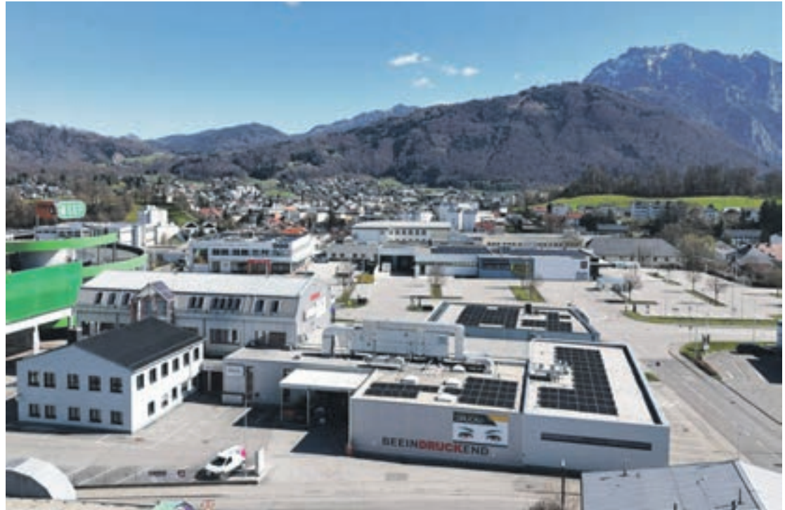
Am Standort von SKG Druck in Gmunden wurden in den letzten Jahren 2,5 Millionen Euro in neue Gebäude, neueste Maschinen, eine Photovoltaikanlage und Tiefenbohrungen für die Nutzung von Erdwärme investiert.
