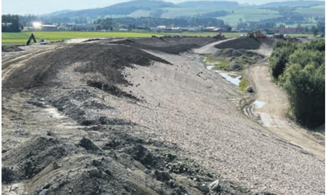
Die Arbeiten am 1,9 Kilometer langen, knapp zehn Meter hohen und bis zu 70 Meter breiten Damm sind in der Endphase, hier wird bereits der Humus aufgebracht.
