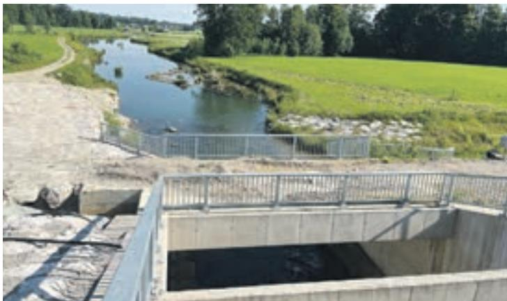
Die Kreams vom Grundablass-Bauwerk aus fotografiert, das zur Regulierung des Wasserstandes und zur Entleerung des Rückhaltebeckens dient.
