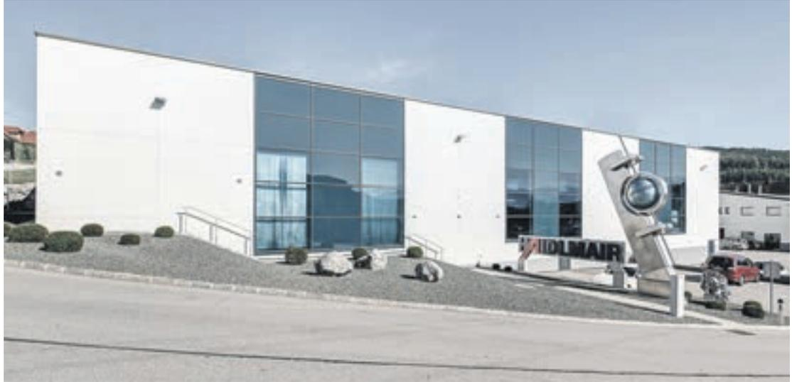
Für die Haidlmair-Gruppe errichtete Gerstl 2016 in Nußbach eine zweigeschoßige, lichtdurchflutete Halle. Die Stahlbeton-Fertigteile stammen aus eigener Produktion.
