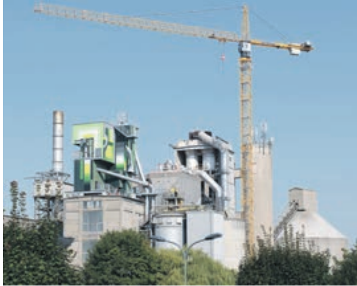
Der über 70 Meter hohe Kran überragt das Werksgelände, die umfangreichen Bauarbeiten im Zementwerk in Kirchdorf haben begonnen.
