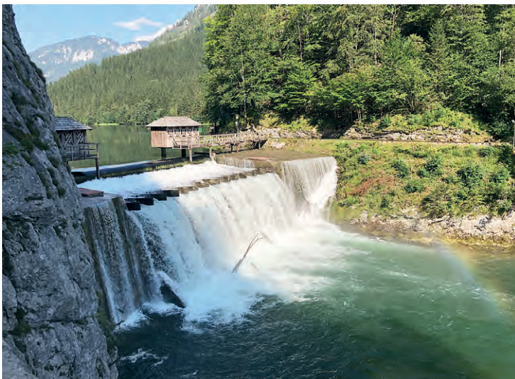
Die Prescenyklause an der Salza in der Ortschaft Weichselboden ist die größte Massivklause Österreichs.
