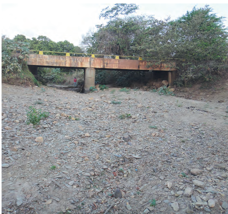
Ausgetrockneter Flusslauf in Riachao das Neves
