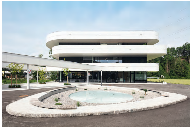
Der neue Greiner Campus in der Unternehmenszentrale in Kremsmünster wurde 2019 fertiggestellt.
