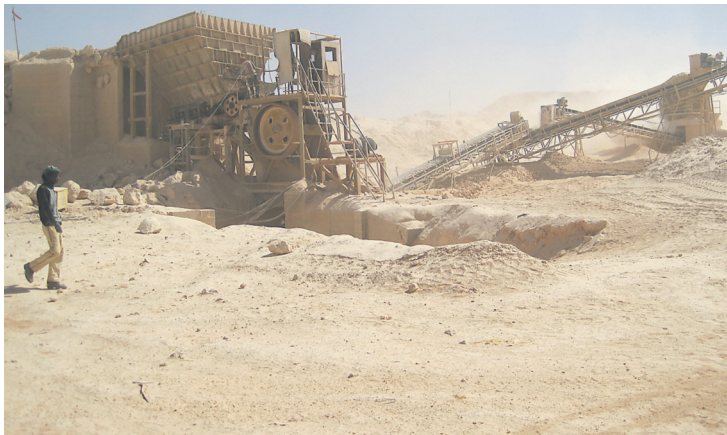
Fünf Jahre arbeitete Christoph Spiesberger für das Betonwerk der Firma Asamer vor Ort in Libyen.
